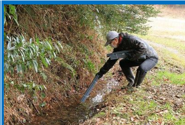
塩ビ管の設置
