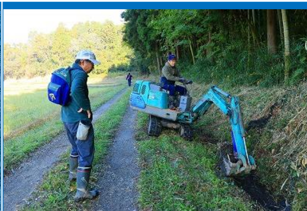
重機による掘削
