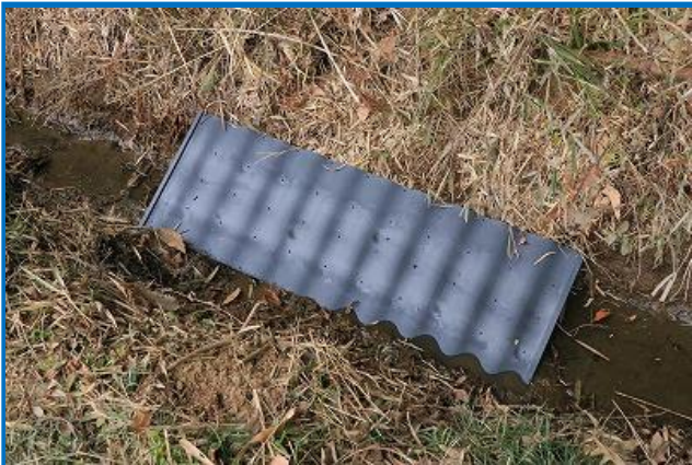
畦畔版の設置
